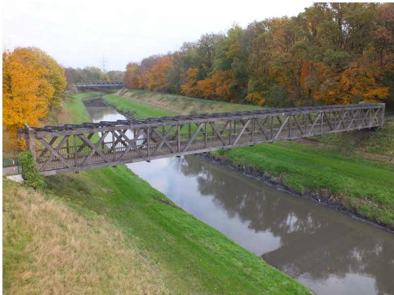
Abb. 4 Holzbrücke über Gewässer
