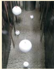
Betontage des Testkörpers
